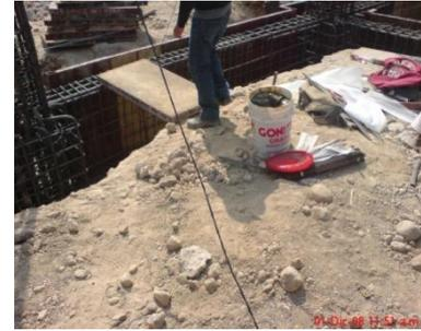
Para facilitar el proceso de descimbrado se engrasa la cara de contacto con el concreto antes de colocarse, para así evitar que se pegue al mismo.
