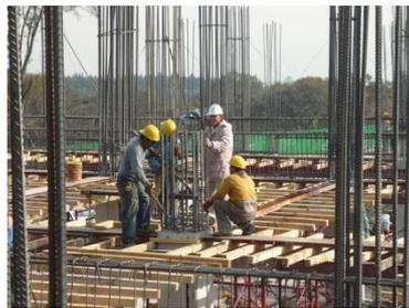
Las siguientes imágenes muestran el remate de las columnas. El acero de éstas se dobló 90° hacia el interior del armado y durante el cimbrado se cuidó el tope de concreto para recibir el último entrepiso como se muestra en la última imagen.
