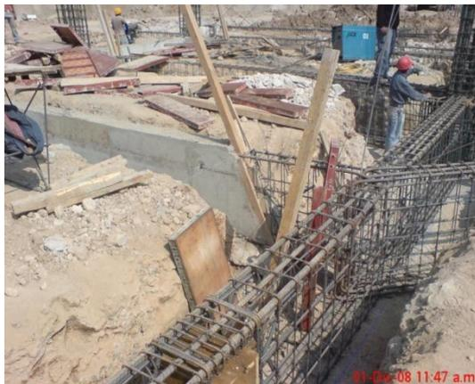
Dependiendo del programa de obra y el procedimiento constructivo, el colado de las contratraves presenta juntas frías, las cuales se generan en un punto determinado según las especificaciones generales del calculista.
