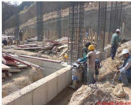
Según la disposición en planos estructurales, los estribos de las columnas, se prepararon después de colar los dados y contratrabes.
