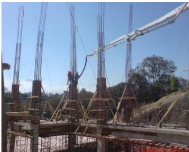
La pluma se utilizó hasta el colado de columnas del nivel +7.35 ya que no tenía el alcance suficiente para los próximos niveles.
