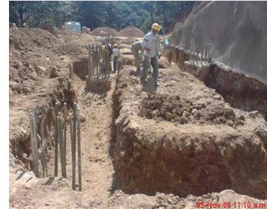
Los ejes 1 y 2 que corresponden al cuerpo 1 se excavaron al nivel requerido descubriendo la sección de pilas a descabezar; ya que como se mencionó anteriormente es necesario retirar el concreto contaminado para continuar con el armado de los dados y ligario con contratraves y columnas.
