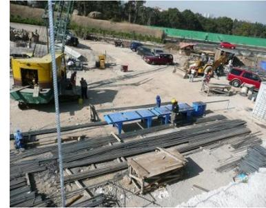
Para mayor eficiencia en tiempos la compañía constructora rentó una máquina dobladora de acero que estuvo ubicada cerca del acceso al terreno, ya que el acero se descargaba cerca de éste y así se redujeron los acarrees de varilla.
